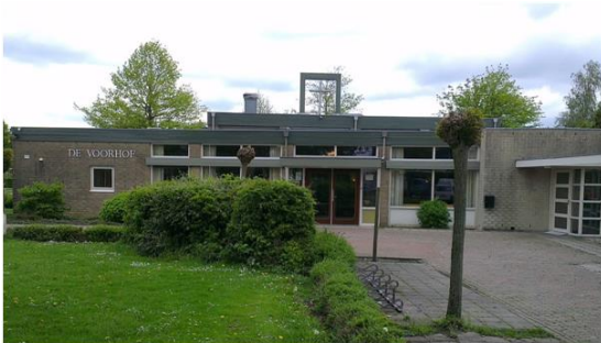
Huidige situatie gevel
